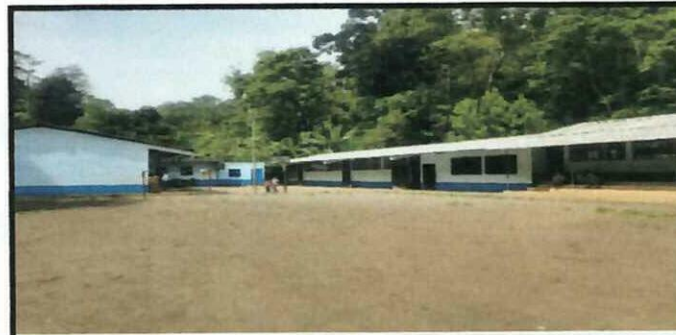
Foto 6: PINTURA EXTERIOR ESCUELA
