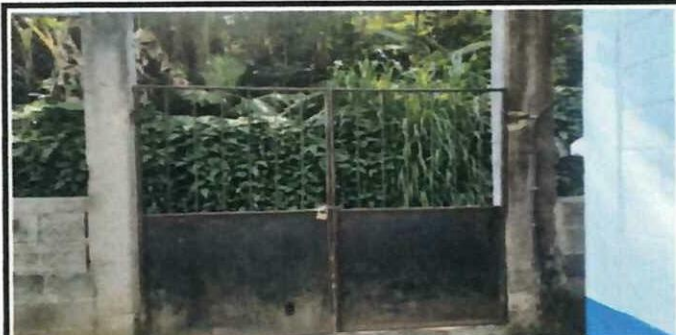
Foto 2: MANTENIMIENTO A PORTONES
