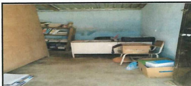
Foto 5: IMPERMEABILIZACIÓN DE LOSA, DIRECCION CICLO BÁSICO
