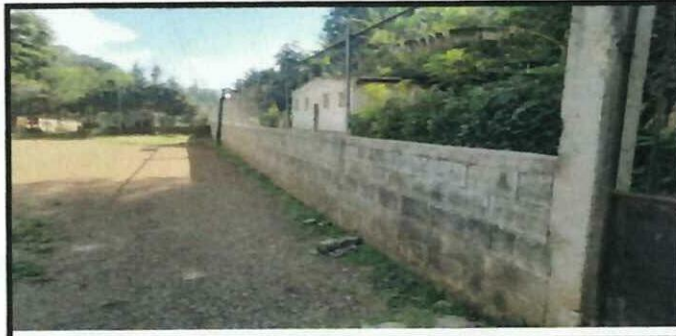
Foto 4: REPARACIÓN DE REPELLO Y CERNIDO DE PAREDES
