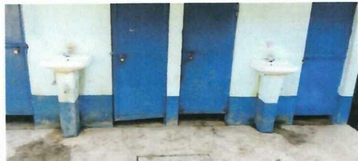
Foto1: SUSTITUCIÓN DE SERVICIOS SANITARIOS Y ACCESORIOS
